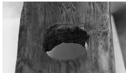
Fig. 213 48材 北端の丸ホゾ穴に残るノミ痕
