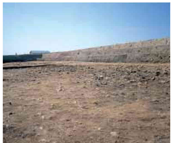
礫敷きの様子(東南から)
