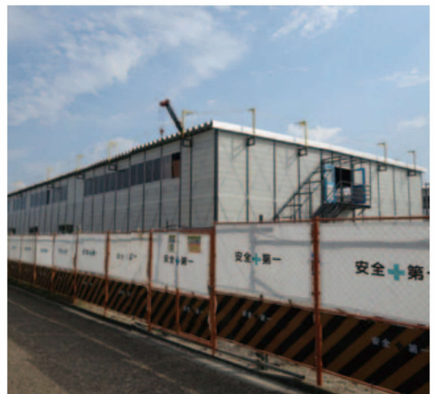
建設中の仮設庁舎
