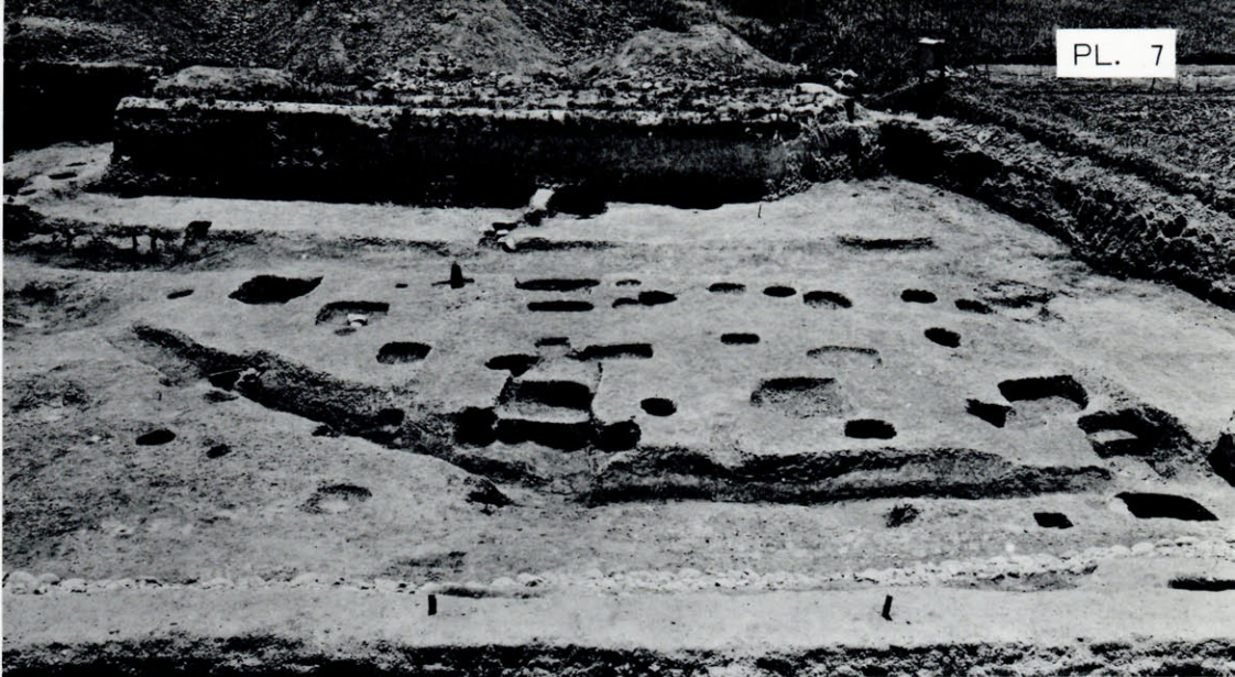
1. SB471建物 SB482建物 SD477溝 北から
