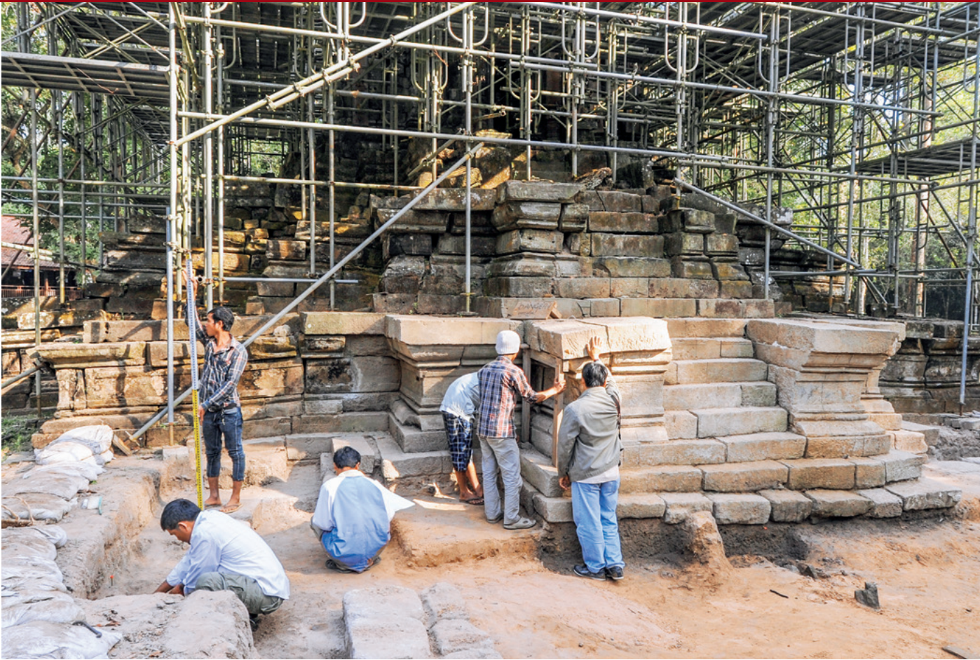
カンボジア・アンコール遺跡群西トップ遺跡の解体修理 Restoration of Western Prasat Top, Angkor, Cambodia
