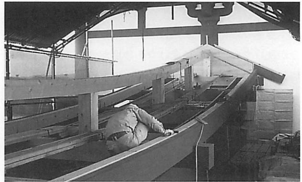
工事中の大垣
