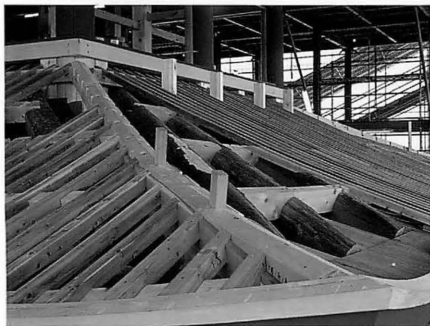
建設中の朱雀門初重屋根
