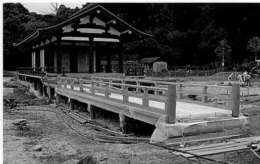
建設中の東院庭園平橋
