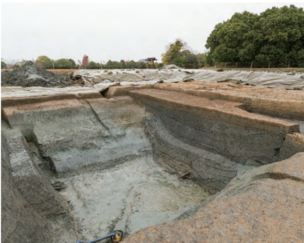
運河完掘状況(南東から、右奥が大極殿)
