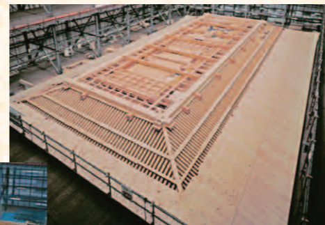
第一次大極殿復原整備 初重野地板施工状況 (2005.12.13撮影)
