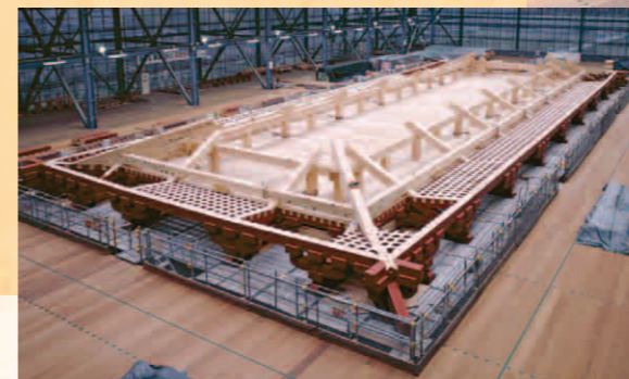
第一次大極殿復原整備 二重軒天井施工状況 ホイス点検台より(2006.06.22撮影)
