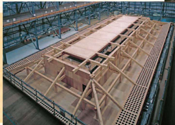
第一次大極殿復原整備 初重尾垂木・小天井格子設置 (2005.03.21撮影)
