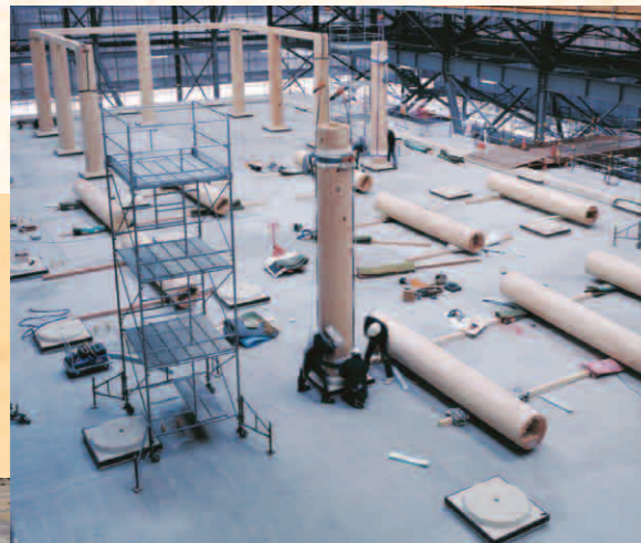
平城宮大極殿基壇 初重立柱 (2004.01.30撮影)
