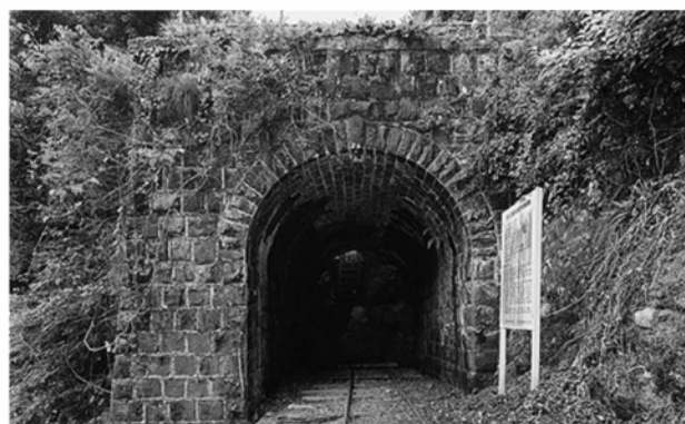
図59 五味隧道 西坑門
