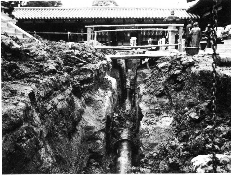
1. 東院の配管工事
