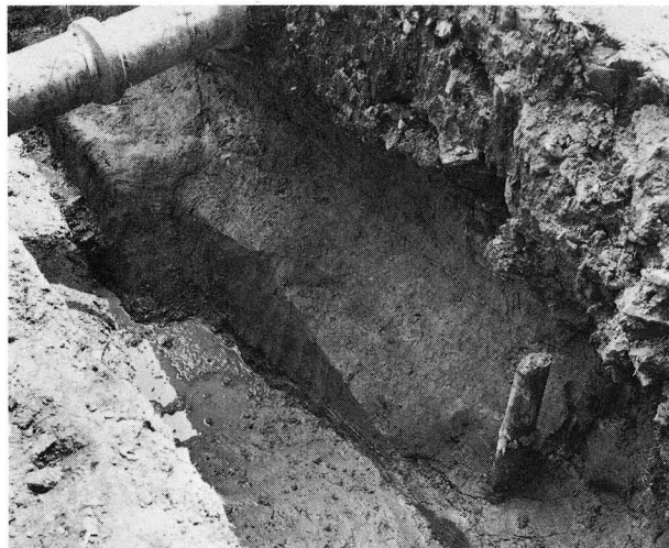
第58図 東院東回廊東南外の古墳時代溝(北東から)205トレンチ
