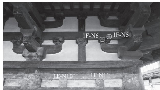
図I-42 初層腰組北面試料採取箇所
