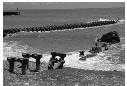
図95 栈橋(旧田野貯木場)
