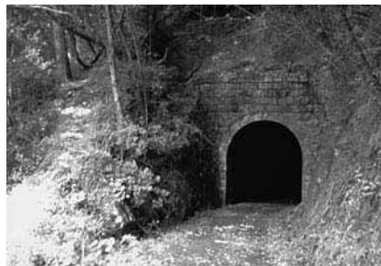
図91 隧道(正弘隧道)
