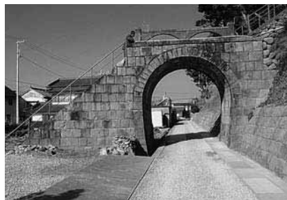
図94 跨線橋(三光院参道)
