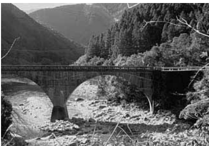
図93 コンクリートアーチ端(二股橋)
