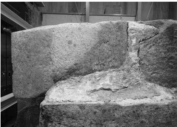
図146 天井石と壁石の目地を塞ぐ漆喰（天井石1・2と東壁石1）
