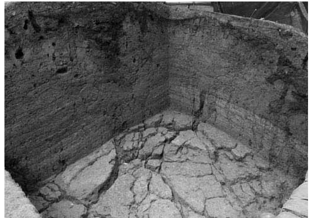
図141 版築層の断面と縦横に走る地震痕跡
