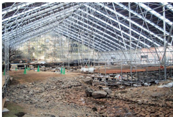
図19 園池修復状況
