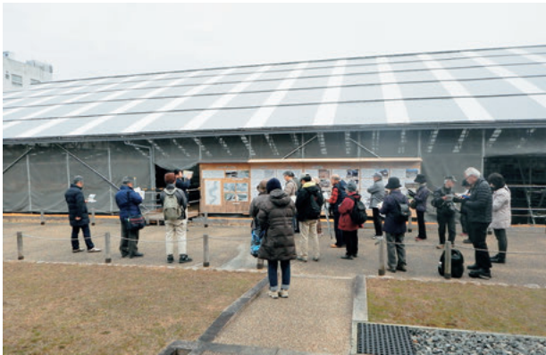
図20 園池修復作業見学会
