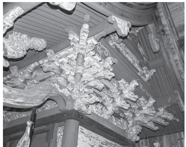
図48 浅間神社（忍野村内野）本殿 軒下見上げ
