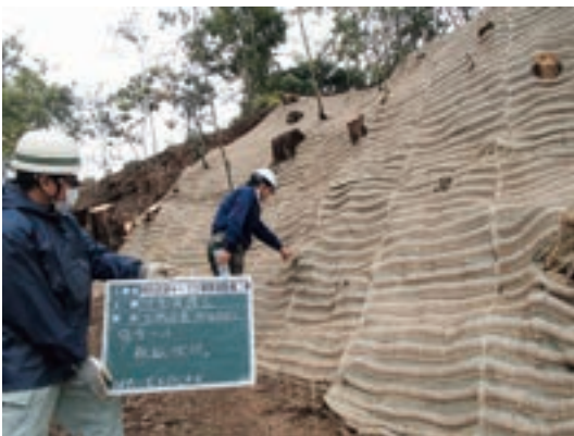
Fig.116 植生マット張り完了 平成27年4月
