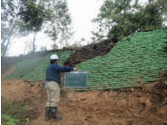
Fig.120 北側斜面東寄り 植生土のう積み完了 平成27年4月
