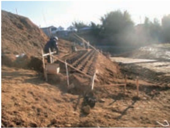
Fig.108 補強土壁施工状況（園路西斜面）①
