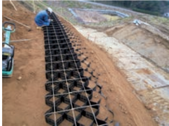
Fig.109 補強土壁施工状況（園路西斜面）②
