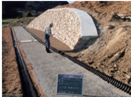
Fig.125 石積擁壁完了
