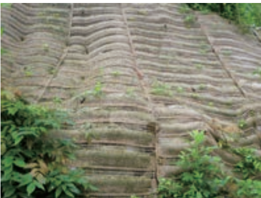
Fig.118 北側斜面西寄り 近景
