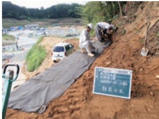
Fig.111 補強土壁工 排水シート施工状況（墳丘西側）
