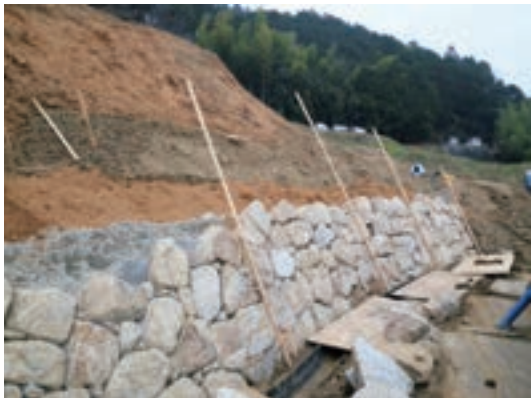
Fig.124 石積擁壁施工状況
