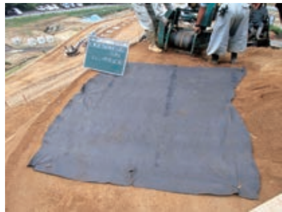
Fig.105 層圧管理材施工状況
