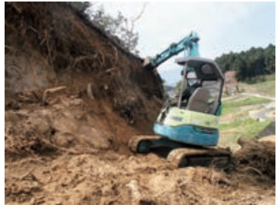
Fig.115 オーバーハング上部掘削
