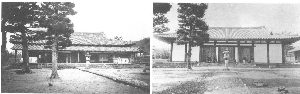
第3図 新薬師寺本堂明治修理における復原(左:修理前、右:修理後)
