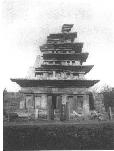
第6図 弥勒寺石塔修理後
