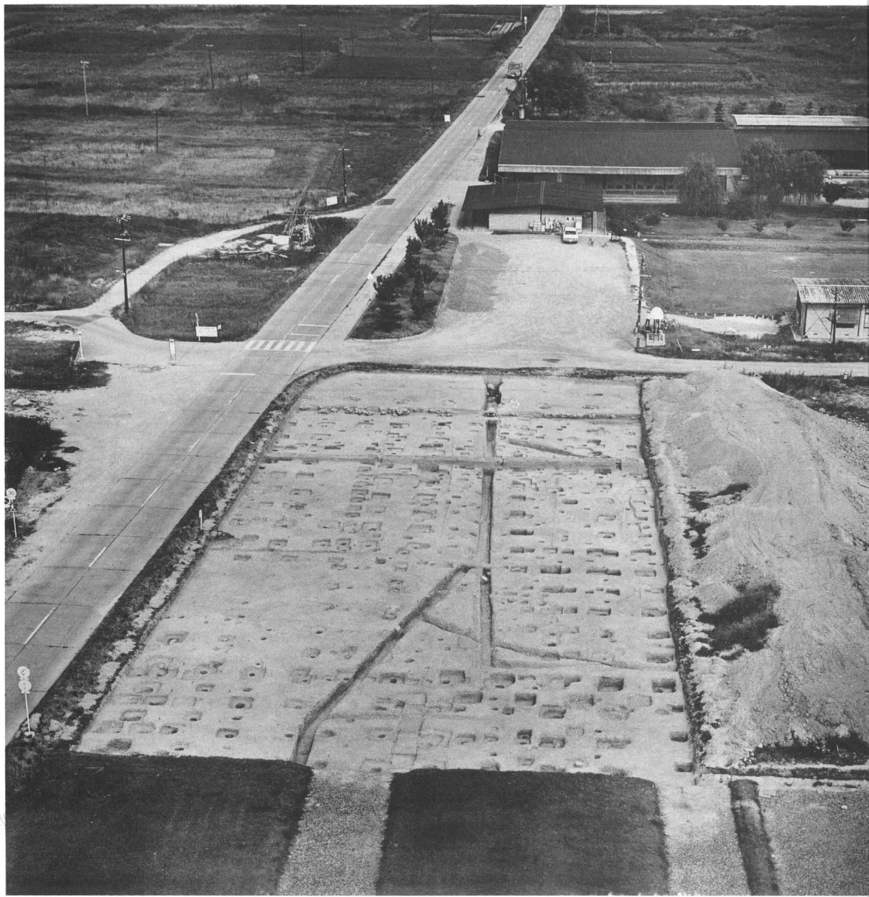
同 西上空から
