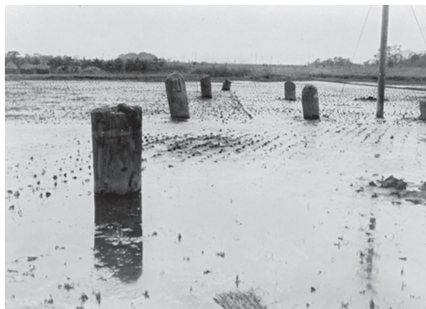
図2 出現時の旧相模川橋脚1
