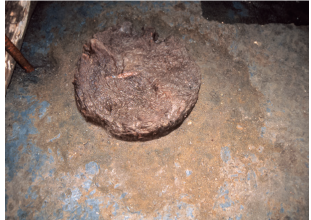
図13 液状化で橋脚の周りに噴出した砂
