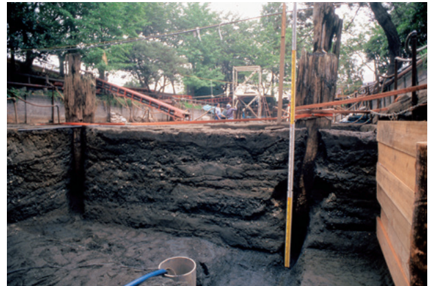
図7 橋脚の下部状況
