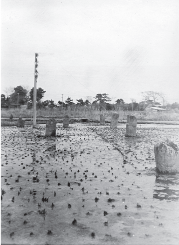
図12 出現後の橋脚の様子3
