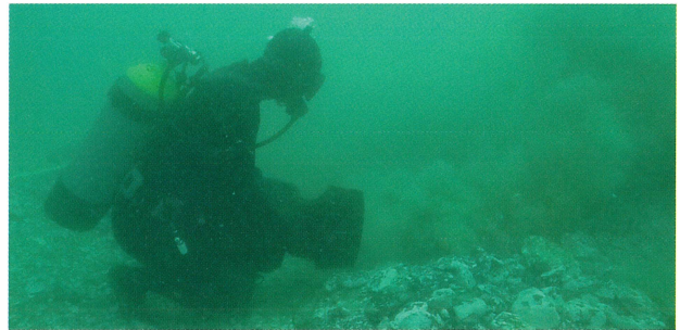
図5 海底面の掘削作業
