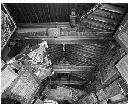
図32 礼堂内部の架構
