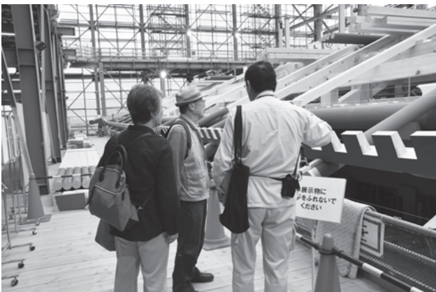
南門復元工事現場の特別公開における来客者への対応（2019年10月26日）撮影：奈文研
