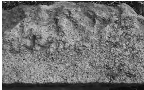
6 ノミ叩き技法→ノミ小叩き技法による仕上げ (感恩寺方形石)
