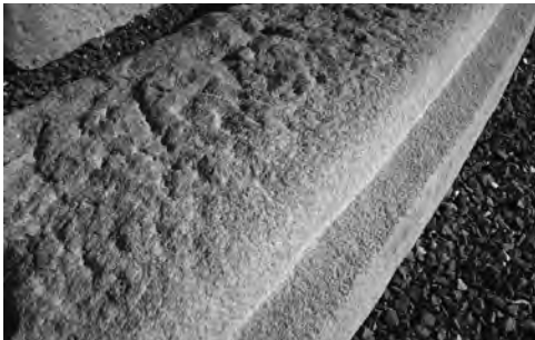
5 ノミ叩き技法→ノミ小叩き技法による仕上げ (未完成王陵甲石 見付段差部分のみ仕上げ)
