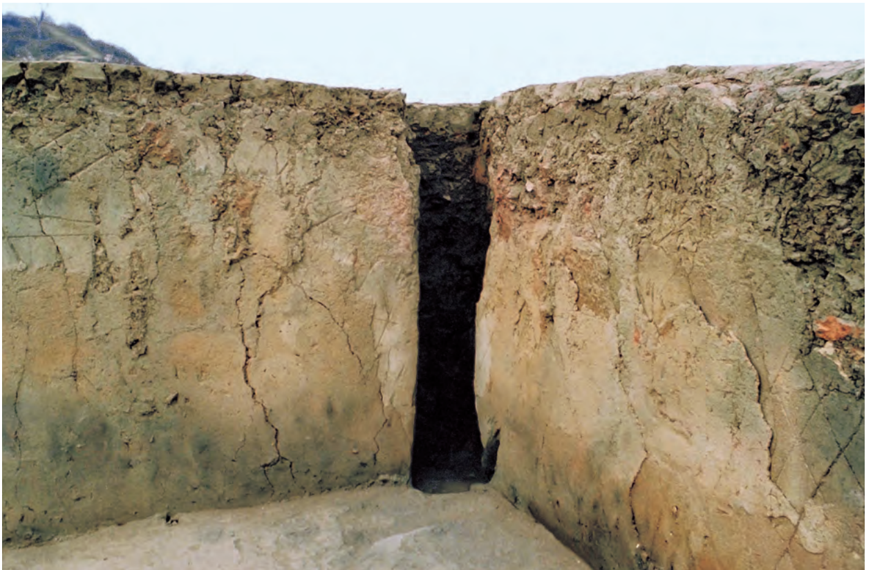
2. 2号建築北院付属建物F2の主室東北隅柱 (南西から)
