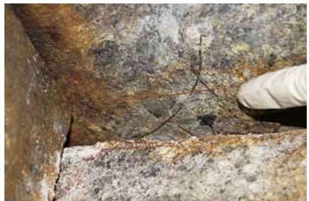
天井石の朱線(左が東、下から見上げる)
