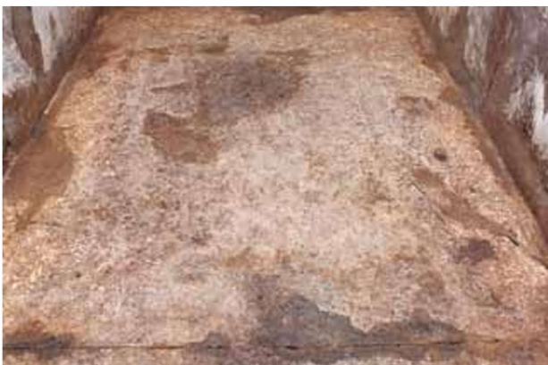
床面の棺台痕跡(南から)
