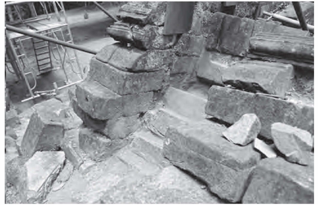
図15 西トップ遺跡北祠堂南面開口部壁材の取りつき
