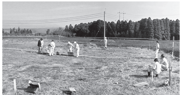
図3. 遺構保護施設着工前
