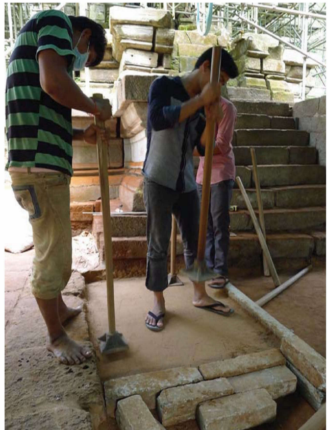
「象の足」と呼ばれる棒を用いて改良土の締め固めをおこなう Compacting foundation soil using an "elephant's foot" rammer
