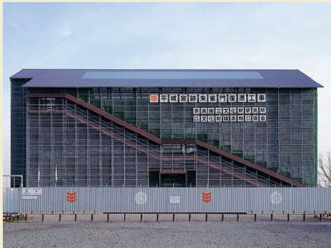
건설용 보호각 (임시지붕) 의 조립 (건설시 발판이 되는 동시에 비·바람을 막아줌)
