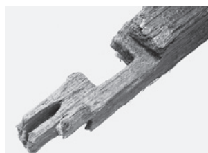
図265 上段土居桁（西側）の相欠と継手
