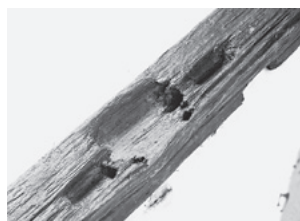
図266 上段土居桁（西側）の間柱部分の仕口
