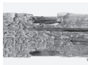
図268 上段土居桁（西側）の欠込部分
