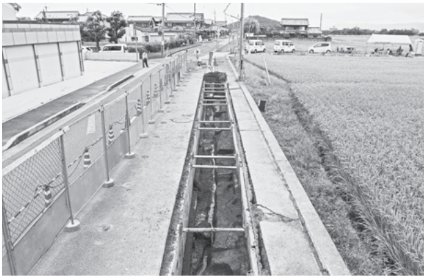
図II-22 第178-2次調査区完掘状況 (X-166,729~-166,746付近 南から)
