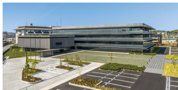
完成した新庁舎（南東から）
