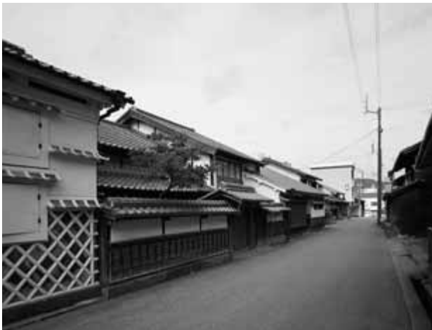
図25 主屋正側面 南西から
