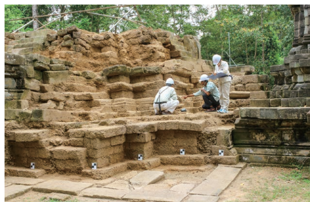
中央祠堂前身ラテライト基壇 建築班調査風景(西から)
