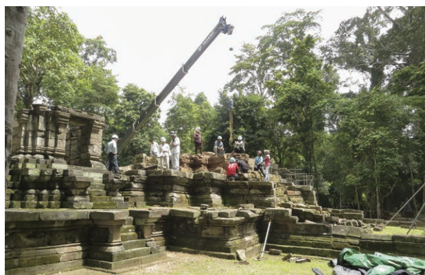
中央祠堂 上成基壇外装砂岩の解体(南東から)
