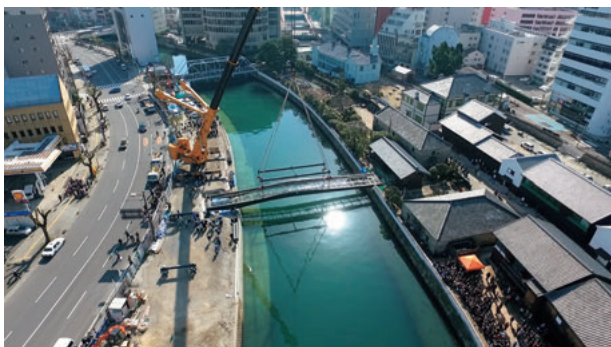
図7 出島表門橋の架橋 多くの関係者、市民が見守る中、行われた (NBC長崎提供)
