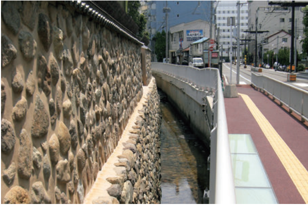
図5 南側護岸石垣整備後の状況
