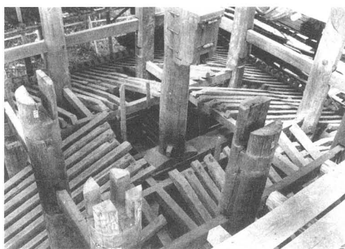
第46図 宝福寺三重塔初重地垂木の状態 (『重要文化財宝福寺三重塔修理工事報告書』p.16)
