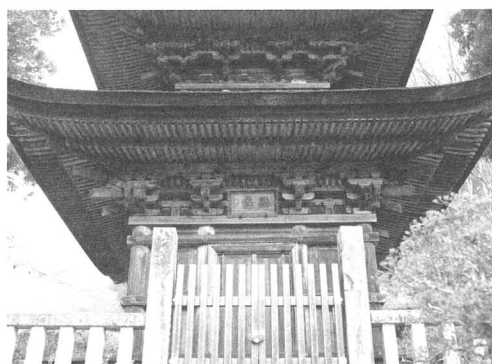
第 32 図 大法寺三重塔初重南面
