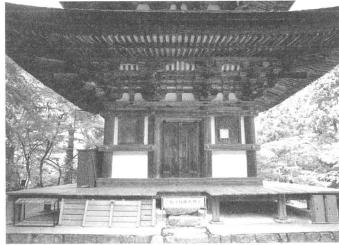
第 28 図 西明寺三重塔初重西面
