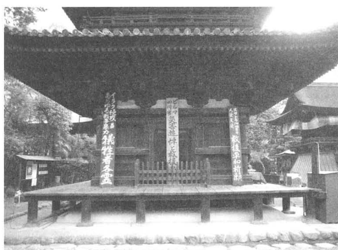
第 30 図 石手寺三重塔初重西面
