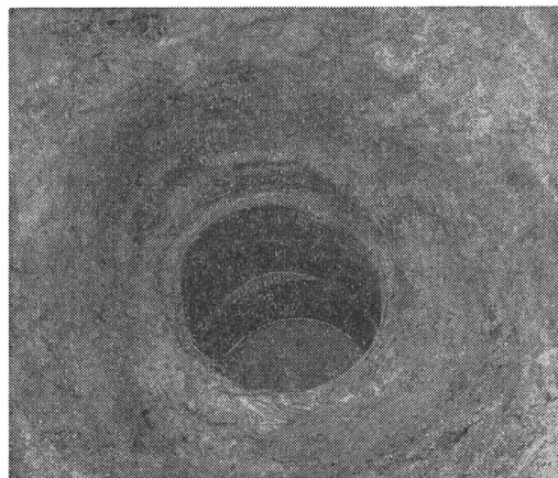
Fig.12 SE1410東 南から
