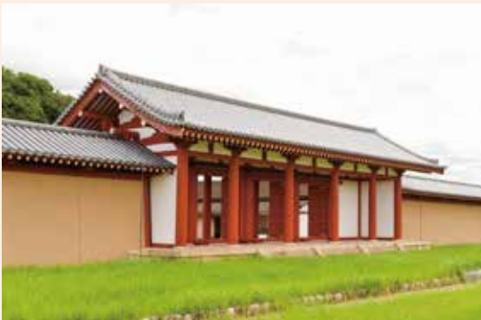
▲ 復元された東院南門(南西から)
