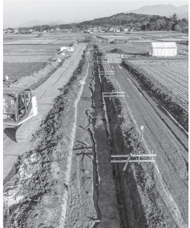
図139 第191次調査区中央部から西部全景（西から）
