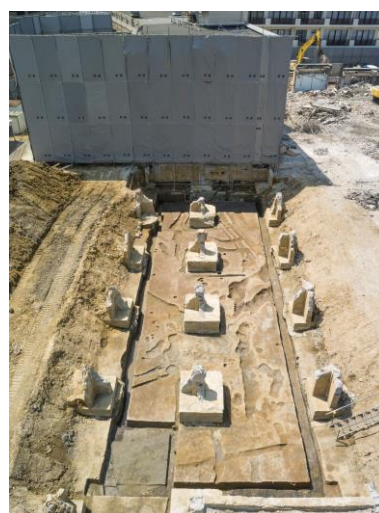
④5/2 高所作業車から撮影した全景です。
