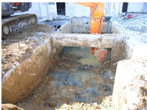
①4/14 地中梁を残して掘削を始めました。
