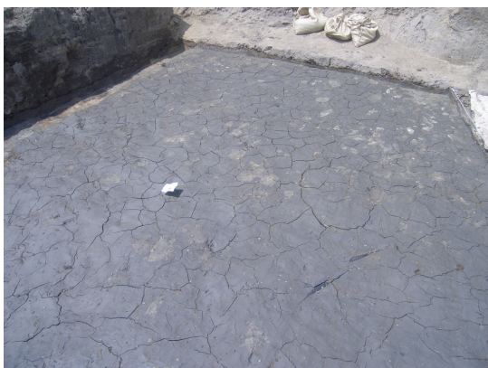
① 7/28 敷葉・敷枝の下には粘土層が広がります。
