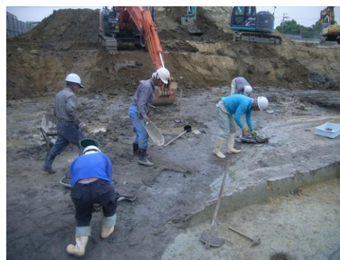
②6/17 秋篠川旧流路の南岸を掘り下げています。
