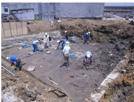
③5/16 旧研修棟部分の調査も始まりました。
