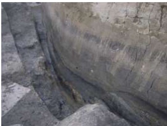
② 9/26 西北部の落込みは 3 m に及びます。
