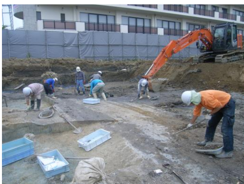
① 6/17 南棟西部分の遺構検出作業です。
