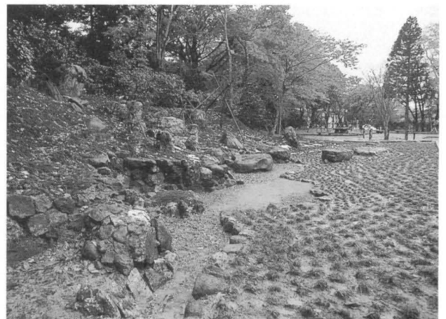
図54 竣工なった庭園全景(東から)
