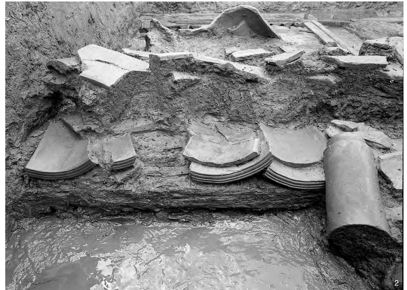
1 南から8・9間目の柱、連子窓、腰壁 上から 2 瓦落下状況(南から8間目) 東から
