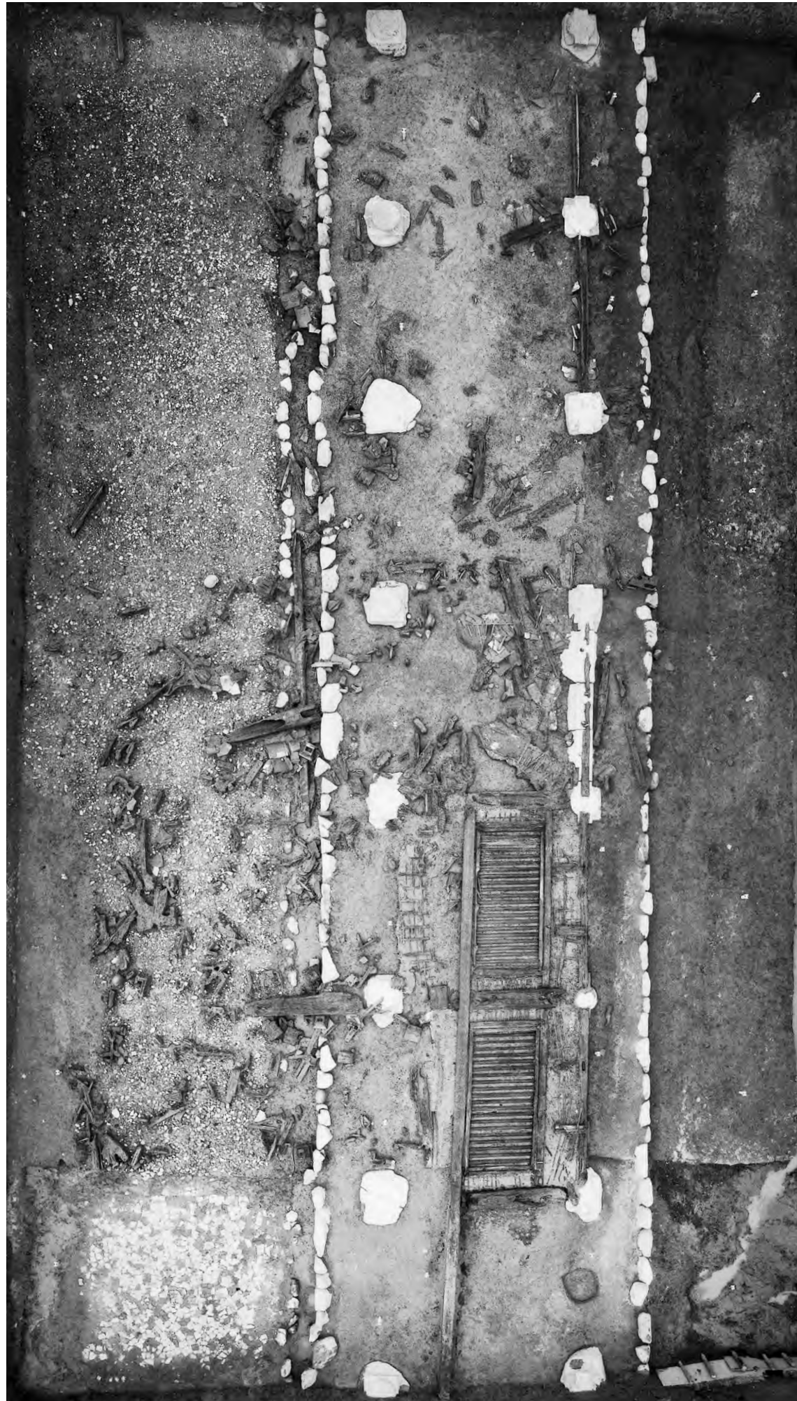
回廊建物倒壊状況(航空写真) 1 : 100
