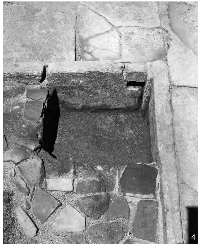
4 金堂南面階段犬走りの水抜き(南面東入隅) 東から
