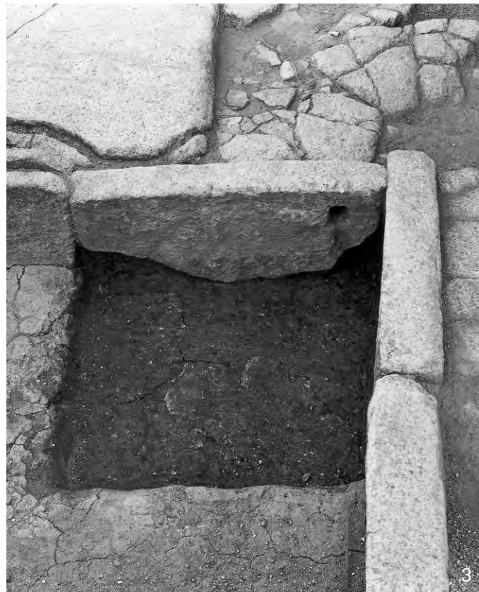
3 金堂東面階段犬走りの水抜き(東面北入隅) 北から
