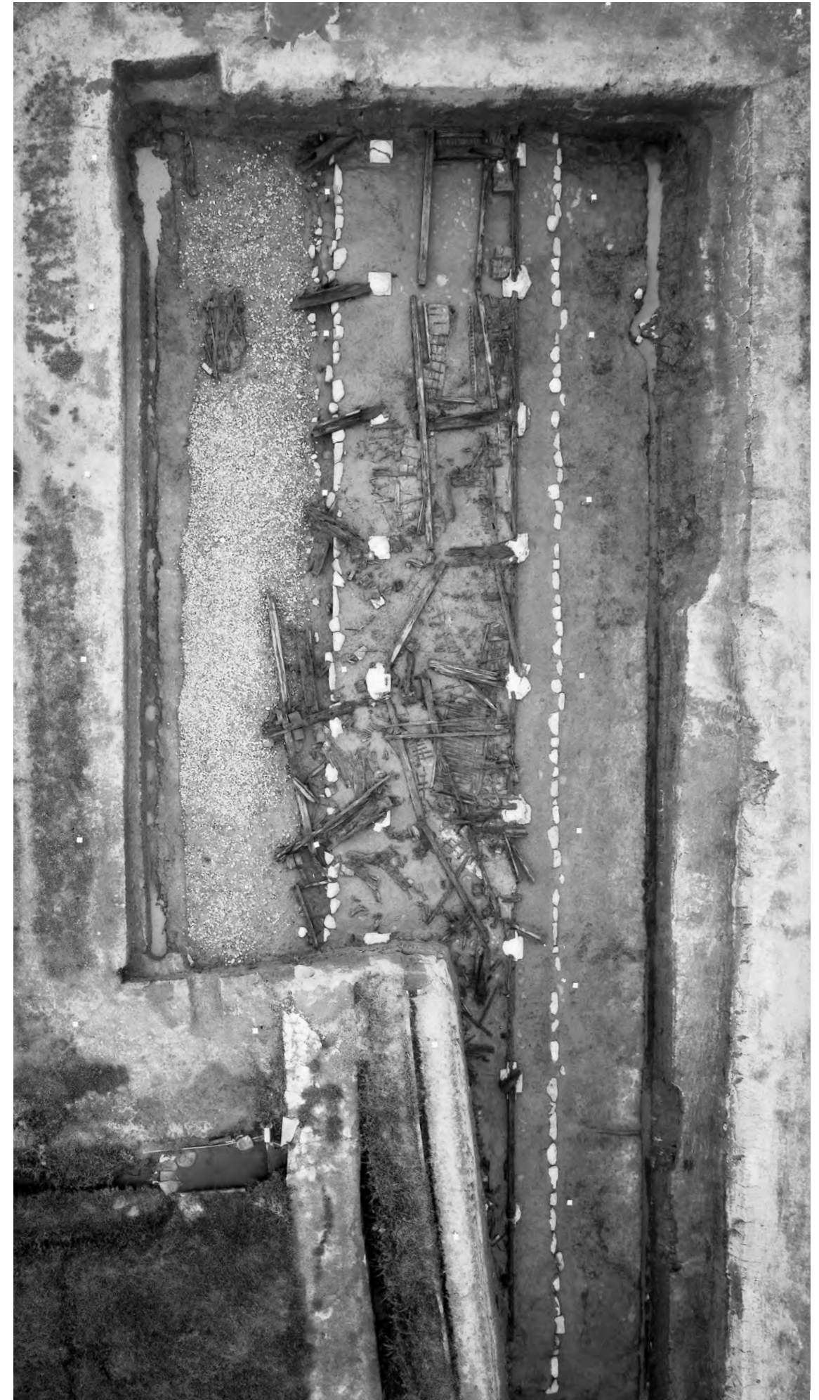
回廊建物倒壊状況(航空写真) 1 : 150
