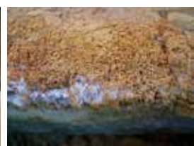
図14 南棟、磚表面の析出物(拡大)(2月撮影)
