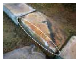
図13 南棟、雨落ち溝沿い磚表面の析出物(2月撮影)
