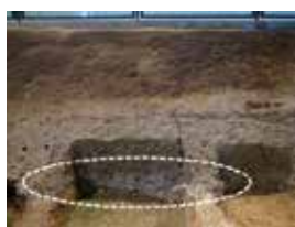
図12 北棟、旧耕作土-遺構面層境界の析出物(東から撮影)
