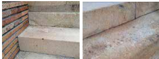
図5 竜山石の石材状態(1階南テラス西階段 ひさし下の剥落)
