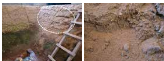
図6 南棟法面の土壌粒子の崩落 (左: 法面全体、右: 左図破線箇所の拡大)
