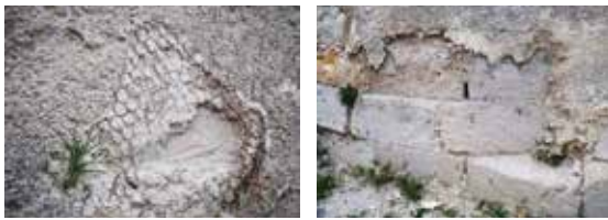
図2：不適切な保存処置の例 (左：錆びた金属メッシュの露出、右：被覆材の剥離)
