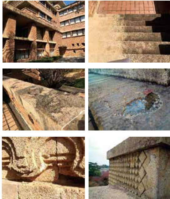
図4 日華石の石材状態(左上:ひさしの黒ずみ、右上:南テラス東階段の藻類繁茂、左中:屋上テラスの笠木の欠損と充填、右中:屋上テラス階段石の表面の割れ、左下:南テラス柱の塩類の析出、右下:屋上レリーフ部の塩類の析出が見られた箇所の欠損)
