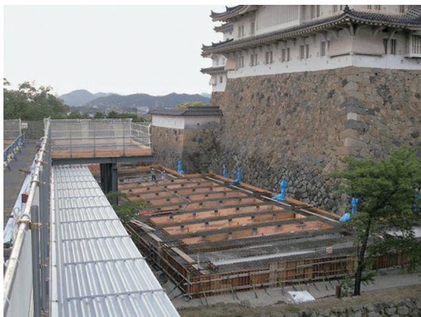
図5 素屋根コンクリート基礎工事（備前丸）
