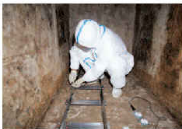
Fig. 39 レールの設置作業
