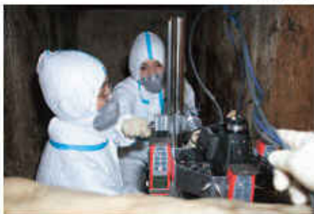
Fig. 15 機材のセッティング
